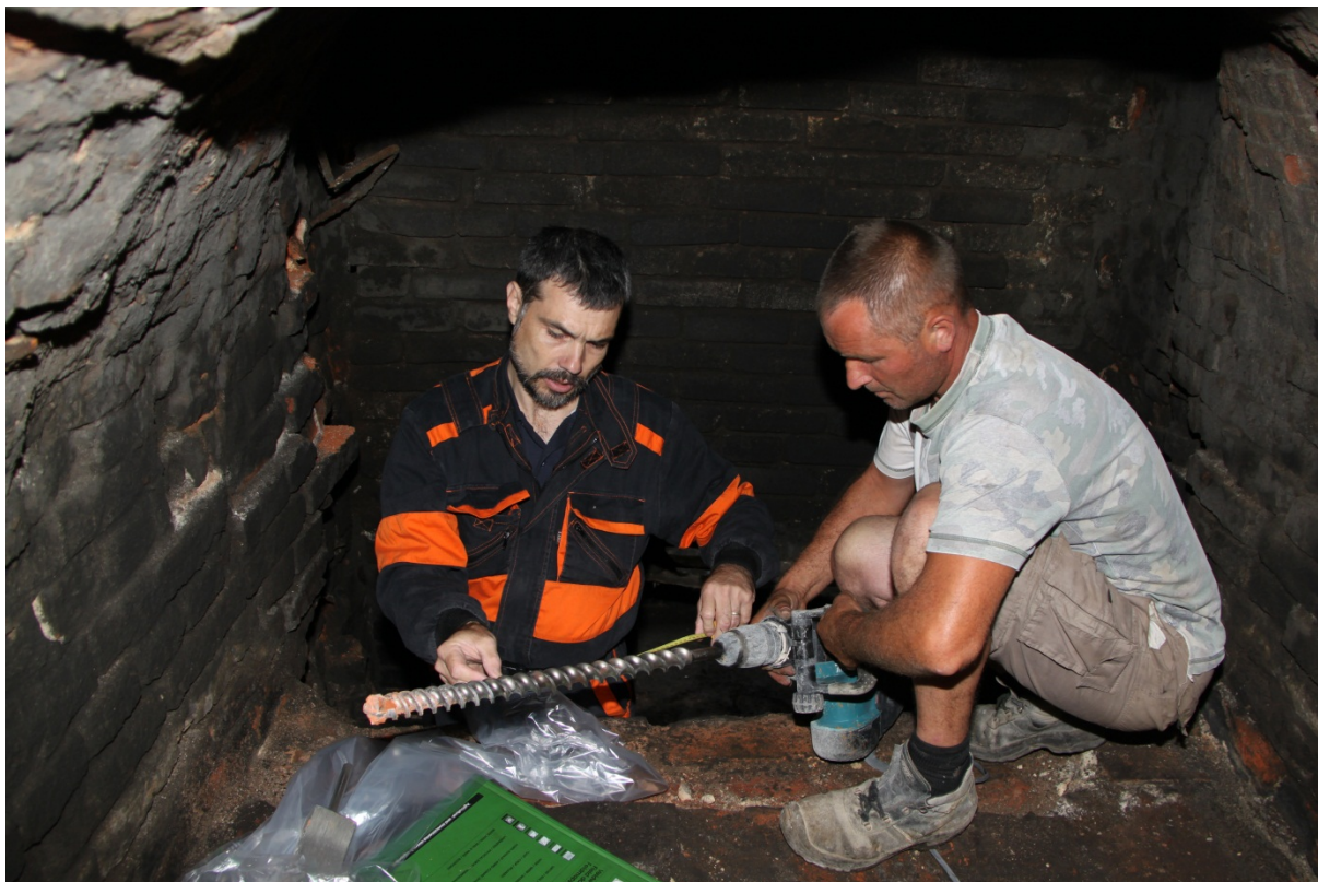
Obr. 3: Kontrolní odběr v patě komínu
