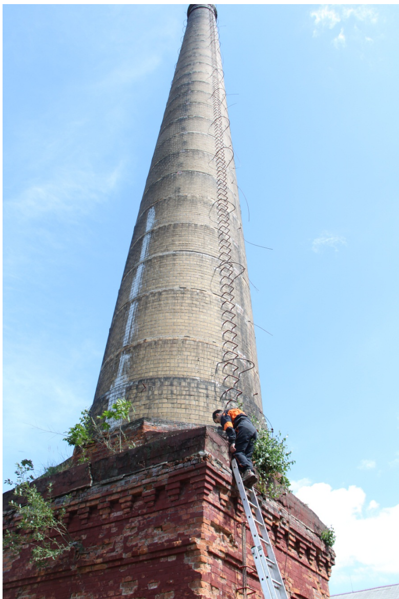
Obr. 2: Celkový pohled na komín
