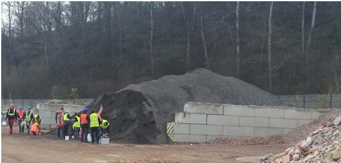
Obrázek 1: Deponie znovuzískané asfaltové směsi
